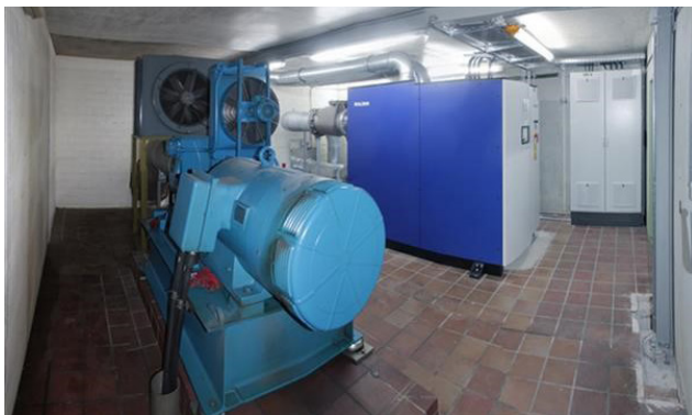
Altbestand (links) und Neuverdichter (rechts) im Parallelbetrieb während der Umbauphase
